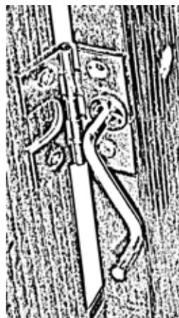
Ослабить винт на 1-2 оборота. Выровнять зазоры между дверью и передней стенкой ящика с карнизом. Винтом закрепить дверь при помощи ключа с таким усилием, чтобы не допустить деформации декоративной петли.
